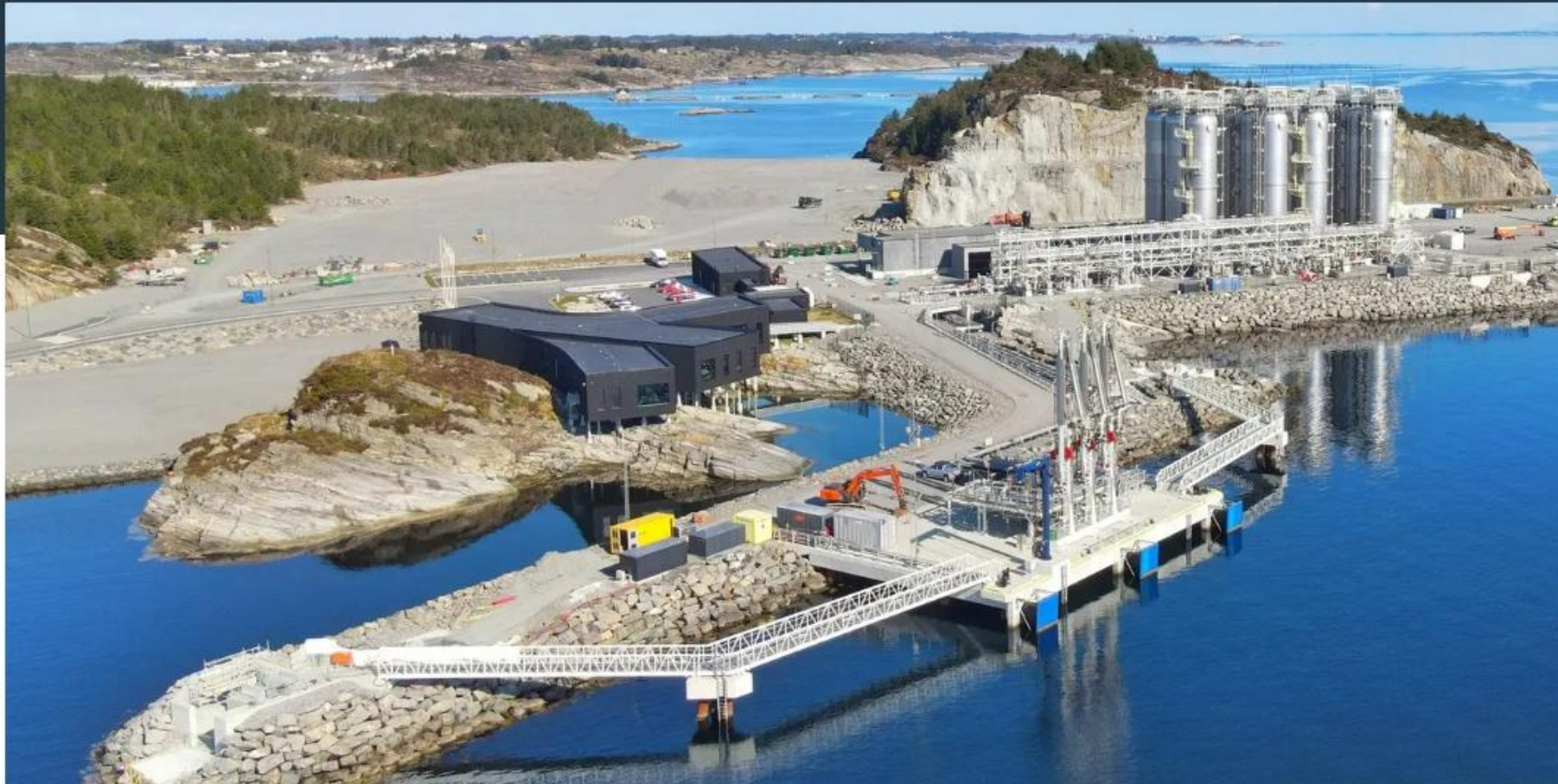
Northern Lights-mottaksanlegget i Øygarden Foto: Northern Lights
