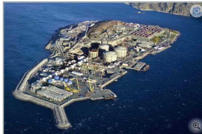
LNG-anlegget på Melkøya.
